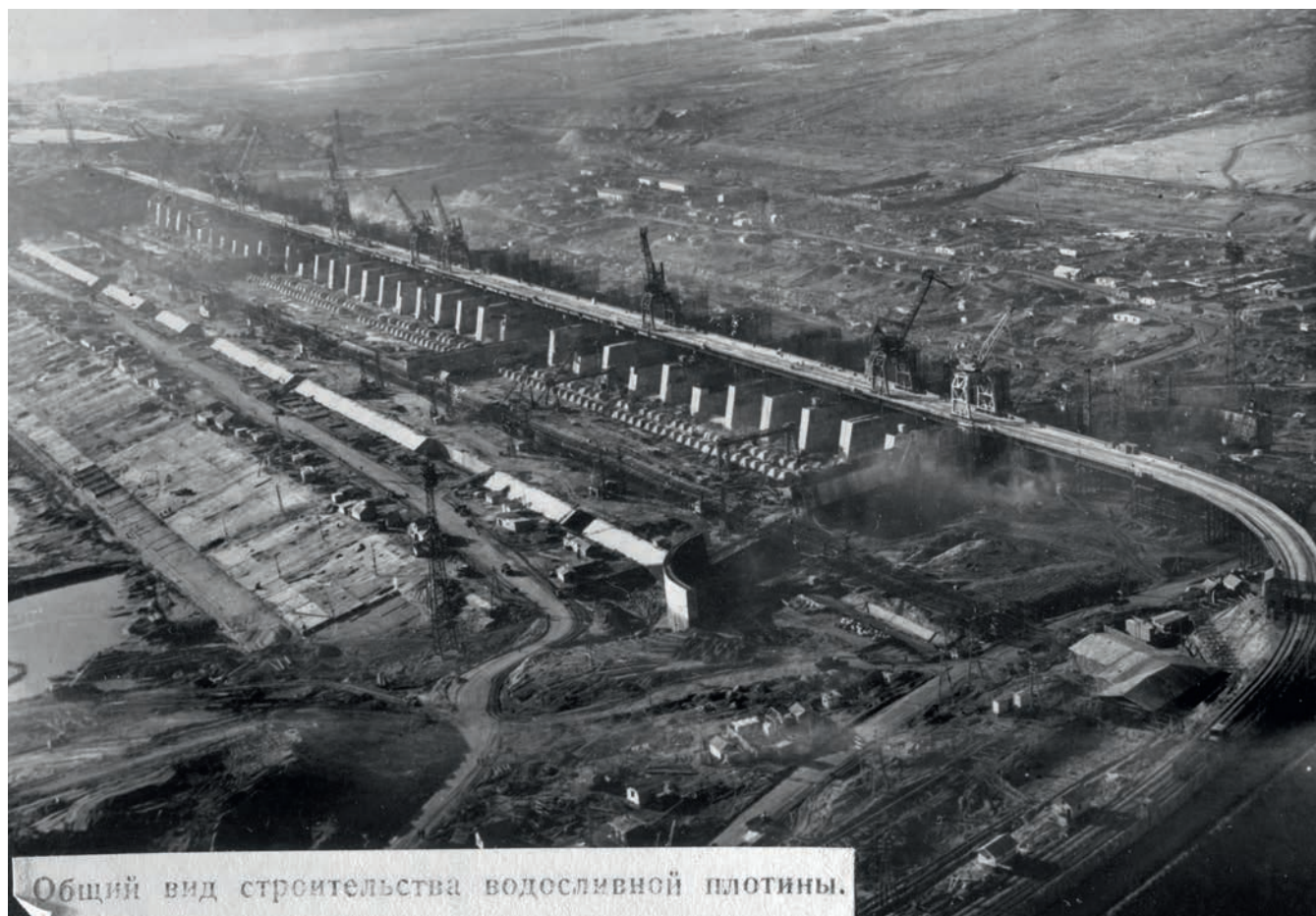
Общий вид строительства водосливной плотины Волжской гЭС им. В. И. Ленина. Из фотоальбома «Куйбышевгидрострой», ноябрь — декабрь 1955 соикм им. П. В. Алабина, кп-16805/ 6
