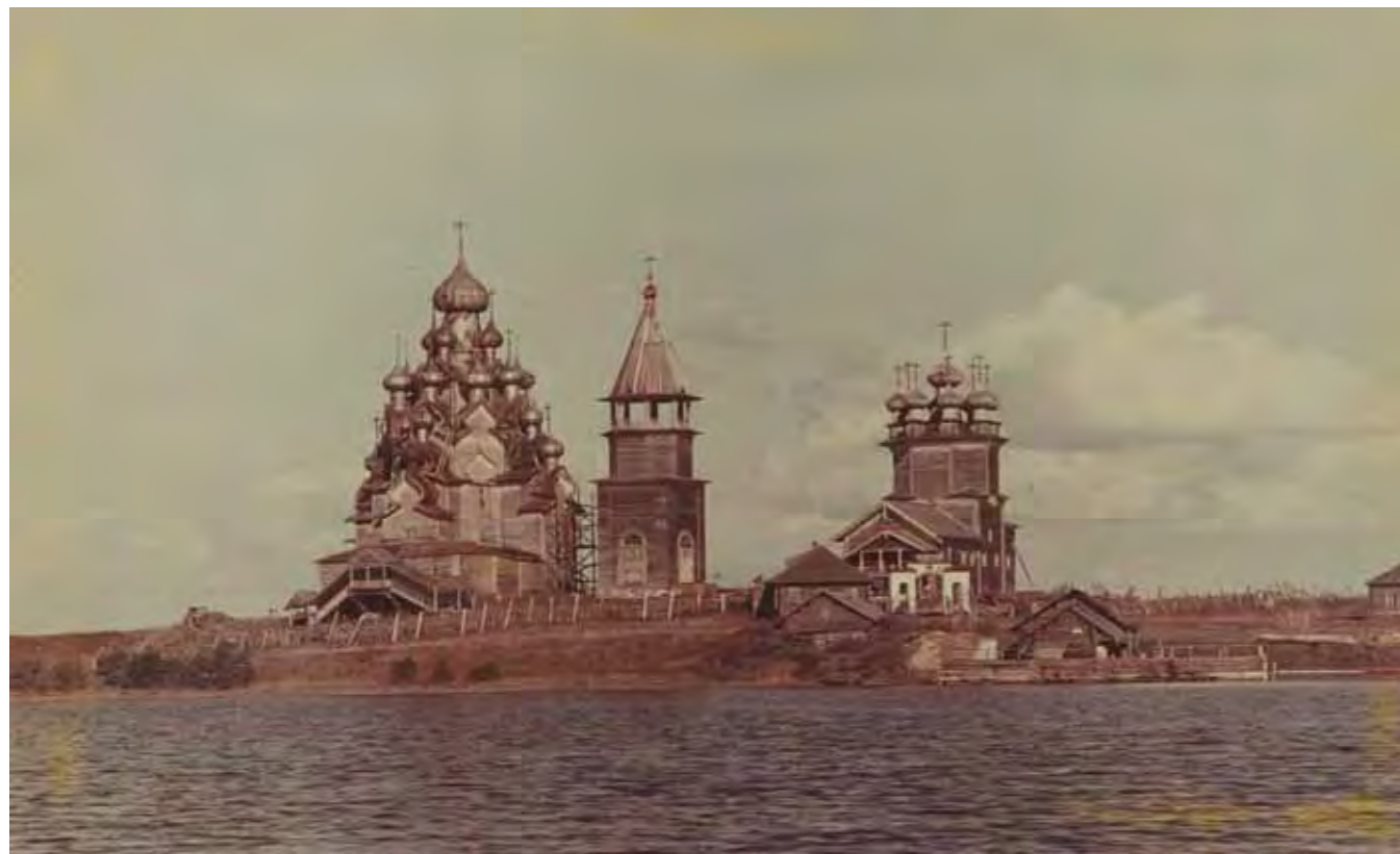
Неизвестный фотограф. Кижский погост. Из фотоальбома «Материалы по деревянному зодчеству К-ФССР». Т. II. Петрозаводск. 1952. 24,2 × 39,0. МЗ «Кижки». КП-4503/2
