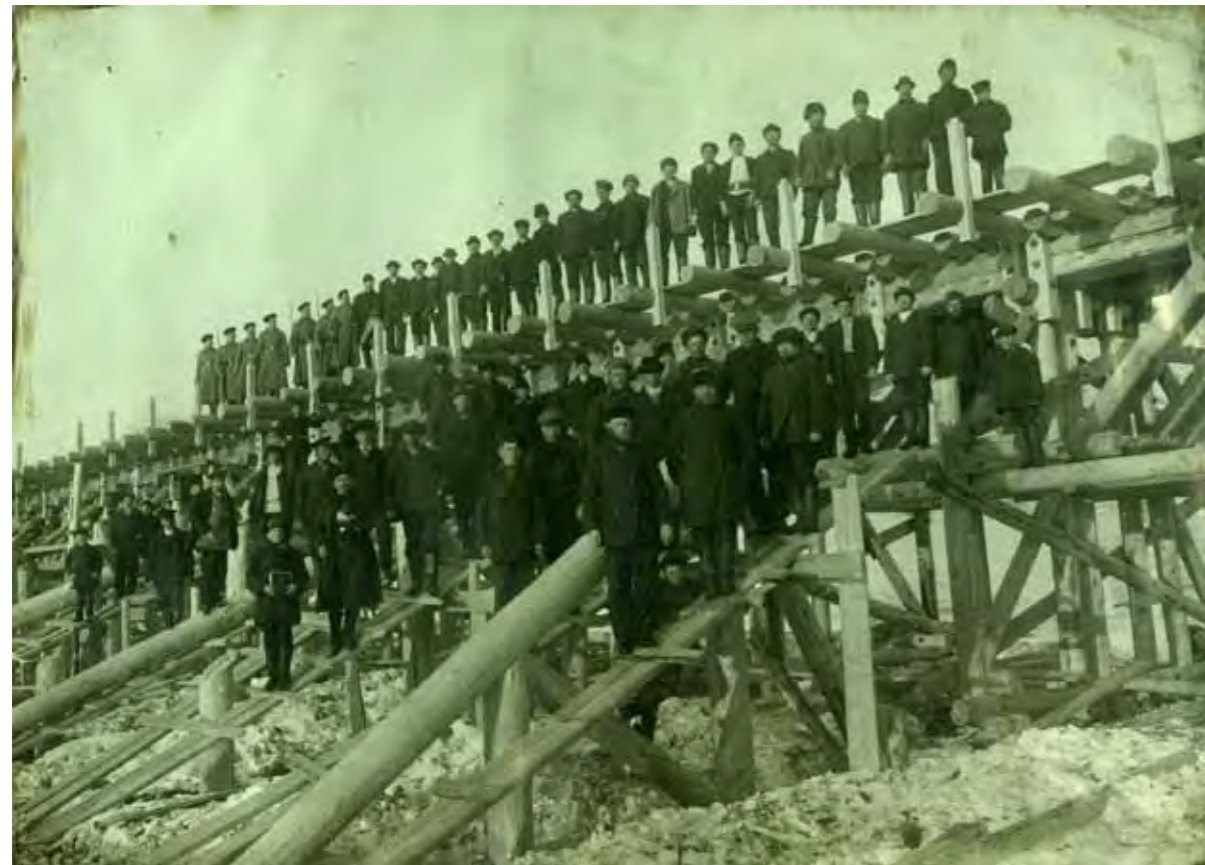
Неизвестный фотограф. Участники строительства железнодорожного моста через реку Шую. (совр. Республика Карелия, Беломорский район). 1914–1916. Коллодионовый отпечаток (?). 17,0 × 23,5. мз «Кижь». кп-2360
