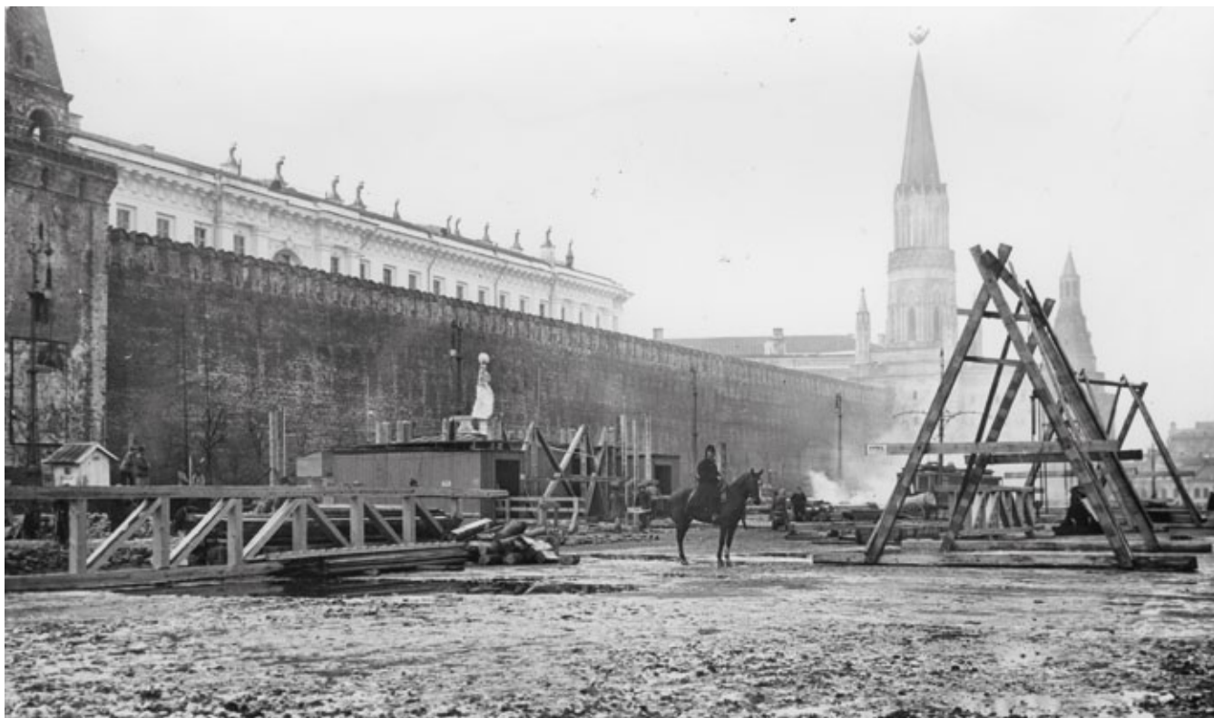
Николай Николаевич Лебедев. Начало строительства второго деревянного мавзолея. Работы по разборке первого деревянного мавзолея в 1924 г. Ч/б негатив, стекло. 13 × 18 см. гнима. Кол. IV-848
