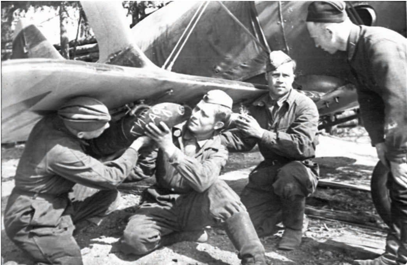
Яков Васильевич Ругоев (1918–1993). Подвеска бомб на самолет техниками 7-й воздушной армии перед очередным вылетом. 1944. Черно-белая фотография, печать на бромсеребряной бумаге с фотонегатива (2,5 × 3,5) на нитроцеллюлозной пленке. ку на рк. Ед. хр. о–60899
