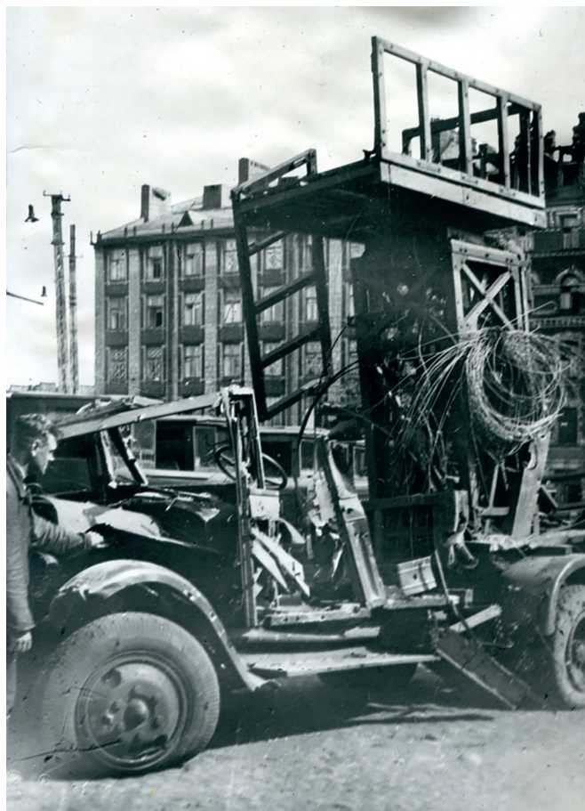
Ил. 3. Автомобиль-вышка «полуторка» ГАЗ-АА после обстрела во время восстановления трамвайной сети Ленинграда. Ленинград. Июль 1942. © АО «Ленгидропроект»
