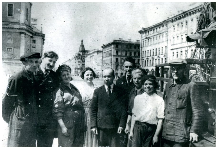
Ил. 5. Группа рабочих и инженеров Ленгидэпа во время восстановления контактной сети ленинградского трамвая. Ленинград. Июль 1942. © АО «Ленгидропроект»
